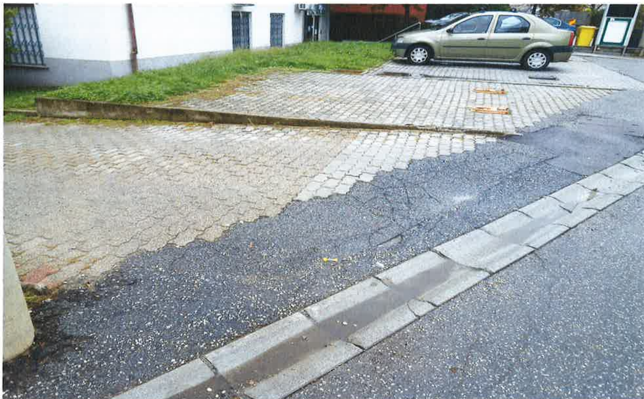
Slika 2 Pogled s pločnika prema jugozapadu. Pristup služnosti je neuredan s lošom izvedbom interventnog asfaltnog zastora na pločniku.
